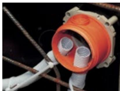
Namontirane savitljive cijevi u tijelo KBT.
